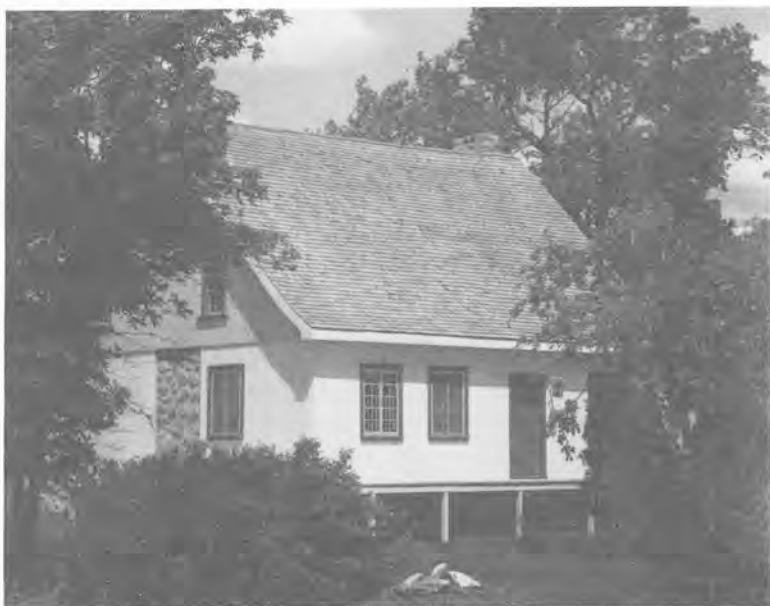
Aspect actuel de la maison Ledoux-Bernard, après rénovation. (Photo: Pierre Lambert).
