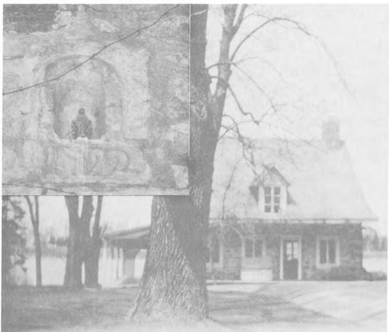
MAISON STEPHEN CLERK, 209, Chemin des Patriotes Sud. Dans sa forme du siècle dernier.
