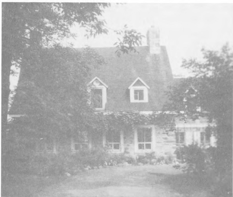
MAISON STEPHEN CLERK, 209, Chemin des Patriotes Sud. Après sa transformation dans les années 1940.
