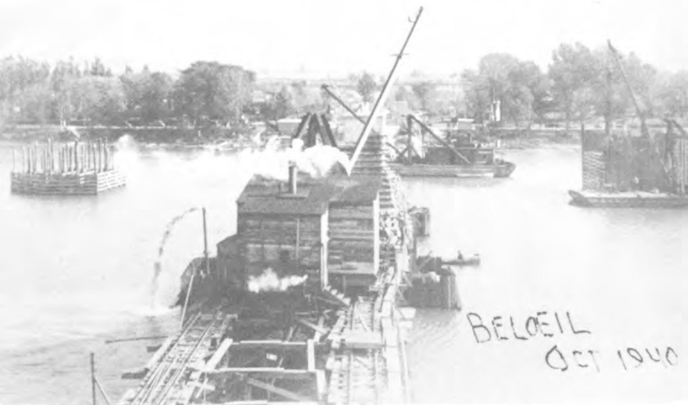
5. LE PONT LAURIER au moment de sa construction. Ce fut la fin du règne des traversiers entre Beloeil et Saint-Hilaire.
