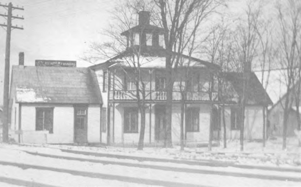
10. L'HÔTEL DES VOYAGEURS existait avant l'Hôtel Balmoral à la Station. Il fut détruit par un incendie en 1915.
