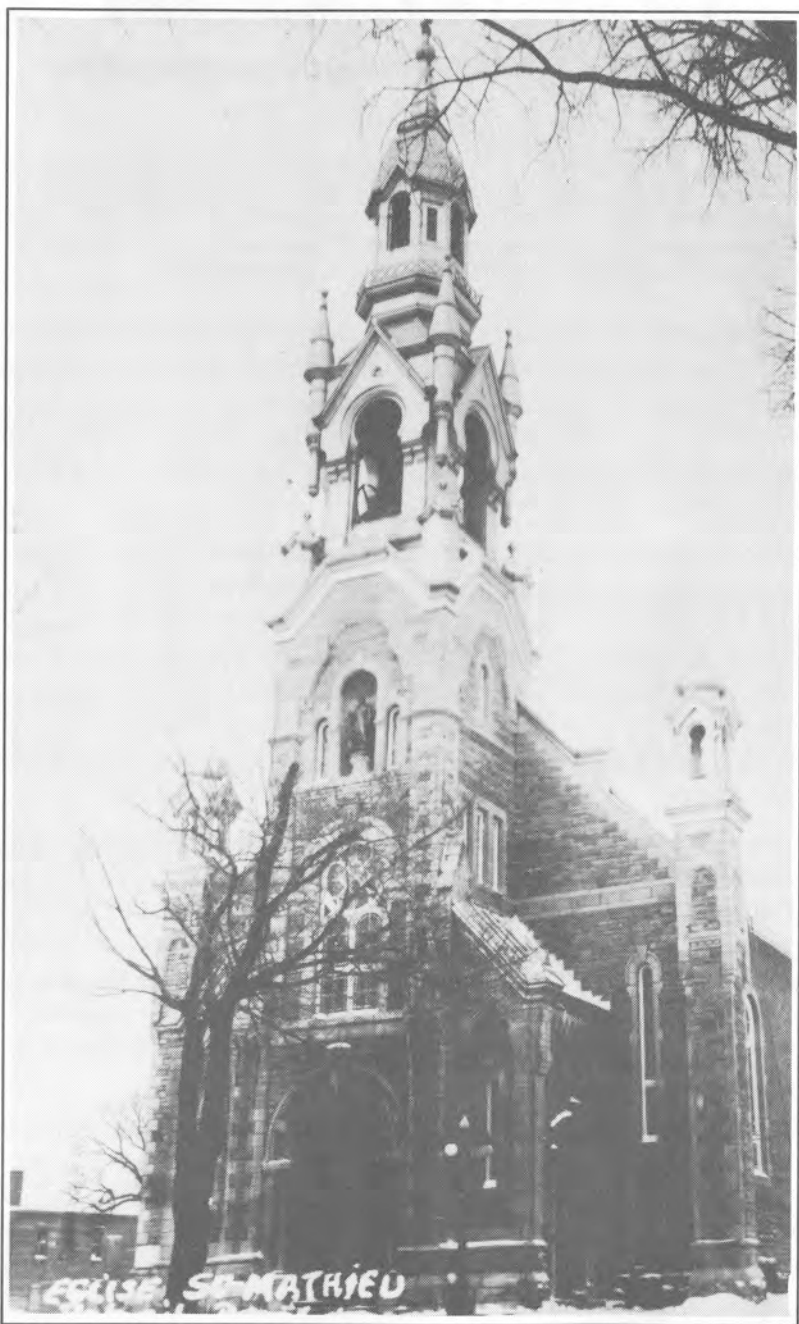
Église Saint-Mathieu, Louis Zéphirin Gauthier, arch. 1896. Vue de la façade (Photographie de la collection Pierre Lambert, Saint-Bruno, Québec.)
