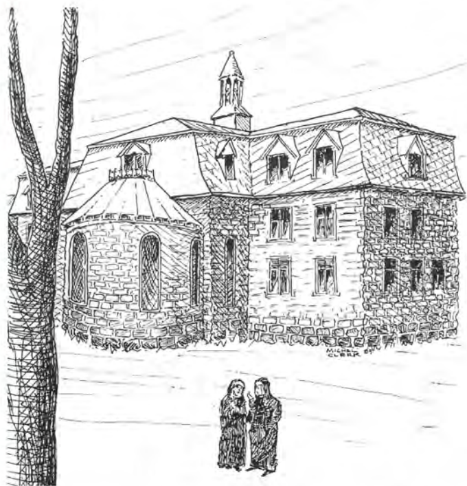
Le couvent de Saint-Hilaire avant l'incendie de 1963.
