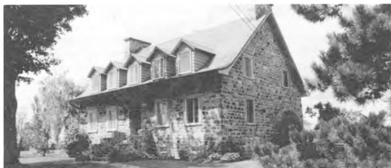
3. La maison d'Augustin Pigeon. P. Gadbois, août 2000. Maison québécoise en pierre, construite en 1824 (Coll. P. Gadbois).
