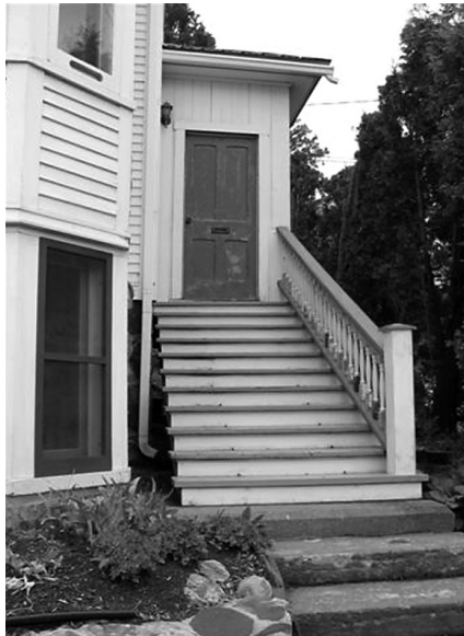
Figure 5. L’ajout latéral jouxtant le mur pignon ouest est l’entrée de la clientèle du bureau de poste. (Source : Coll. Suzanne Cardinal)
