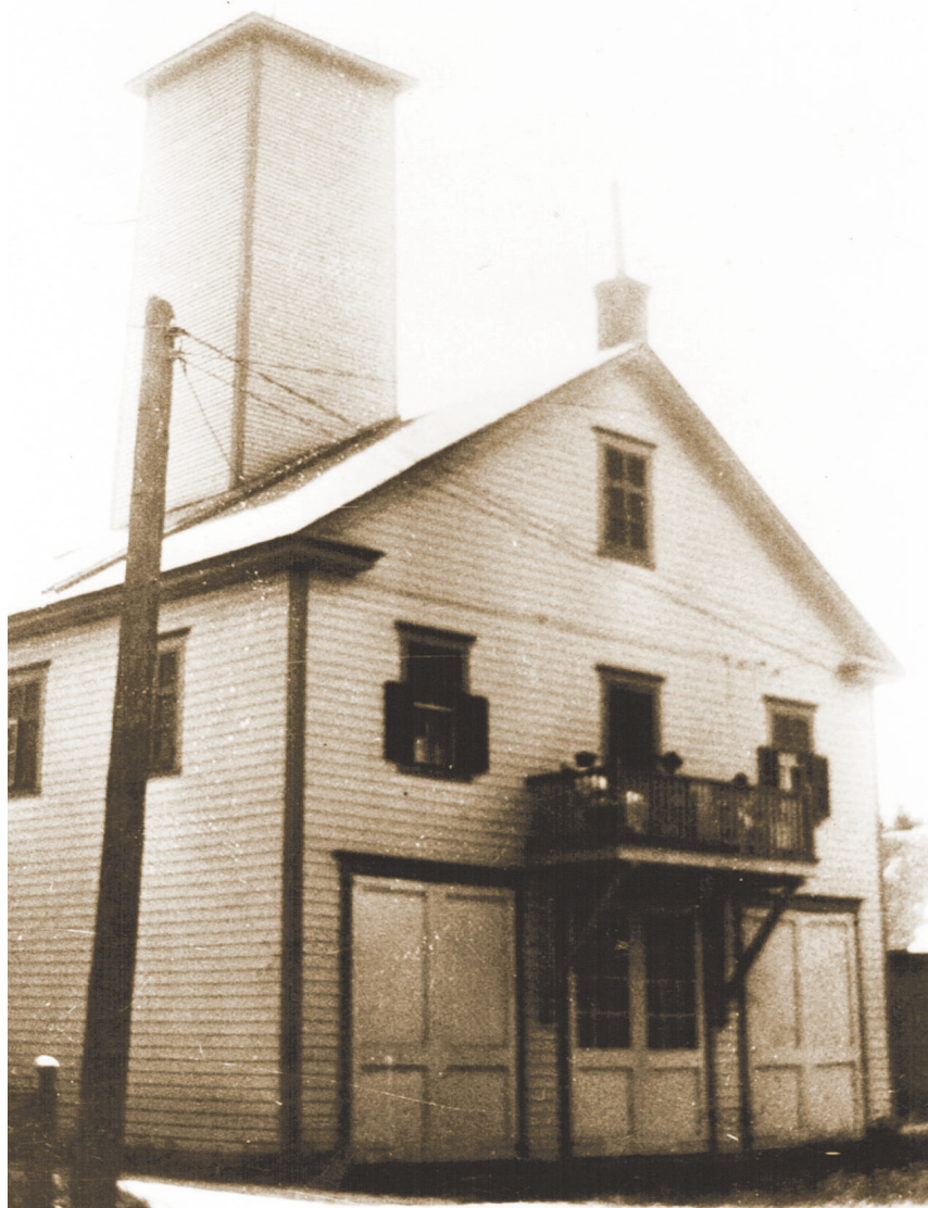
Figure 3. Rare photo de la station de pompe à feu de Belœil, vers 1945 (SHBMSH, fonds Pierre Lambert)
